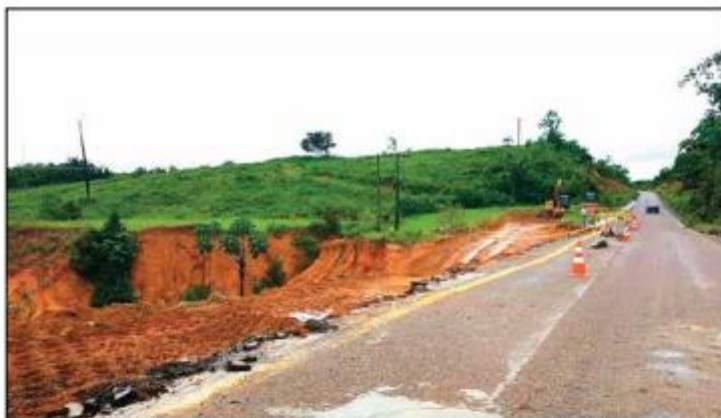
Ordem de serviço já foi assinada e trabalhos abrangerão a recuperação de erosões na via | DIVULGAÇÃO/SEINFRA
