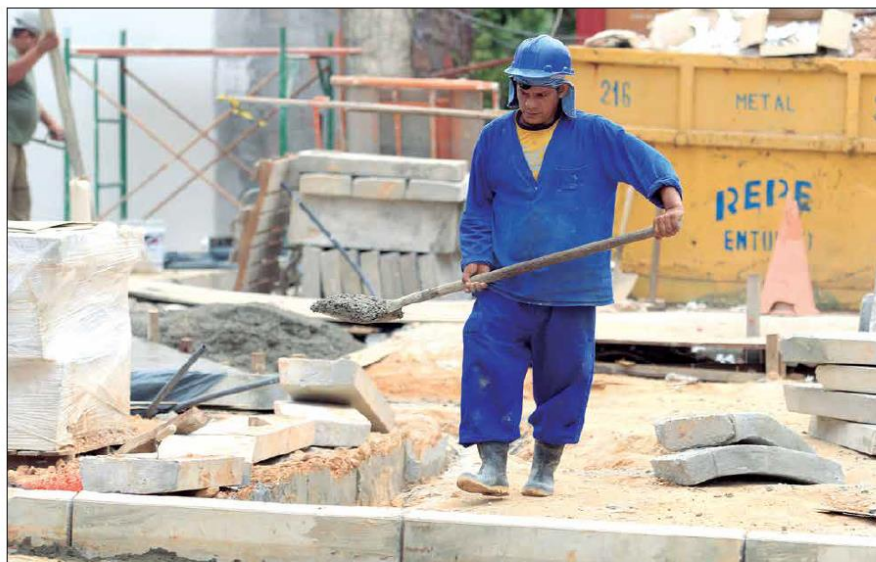
Para entidades, como o Sinduscon-AM e a Ademi, a terceirização deve aumentar as contratações nos canteiros de obras da capital amazense
