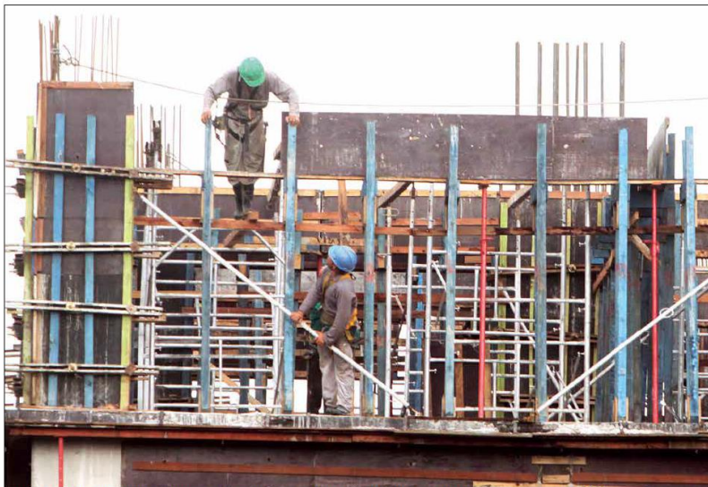
Construção civil é um setor em que é comum as grandes empreiteiras contratarem empresas terceirizadas para fazer serviços nos canteiros de obras | ARQUIVO EM TEMPO
