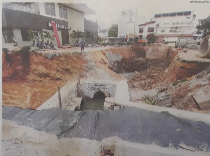
Tubulação foi trocada após análise técnica da prefeitura indicar, no fim de 2017, que as tubulações estavam comprometidas
