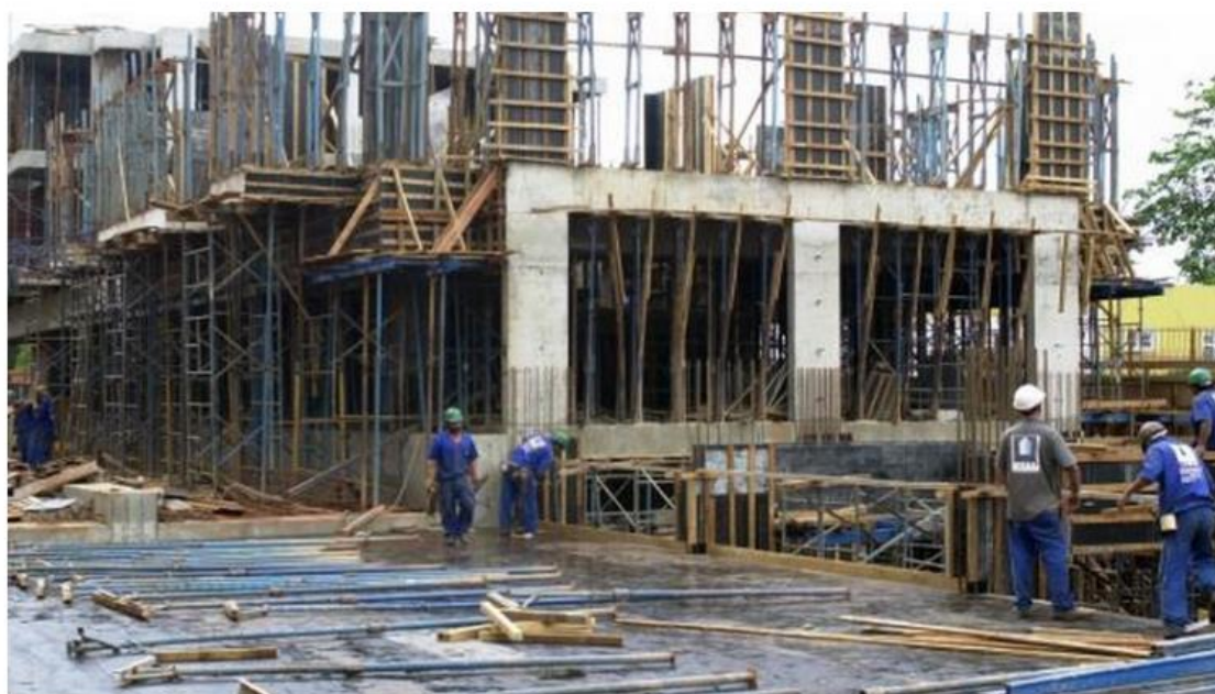
Construção civil deve gerar entre 4 e 5 mil novas vagas de emprego este ano no Amazonas (Foto: Agência Brasil)
