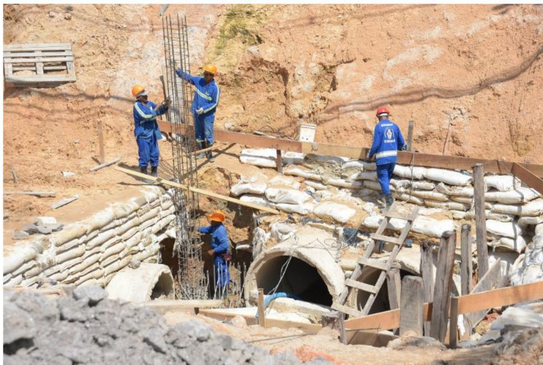
Obra na Djalma Batista passa por processo de concretagem de caixas coletoras (Foto: Diego Caja/Seminf)
