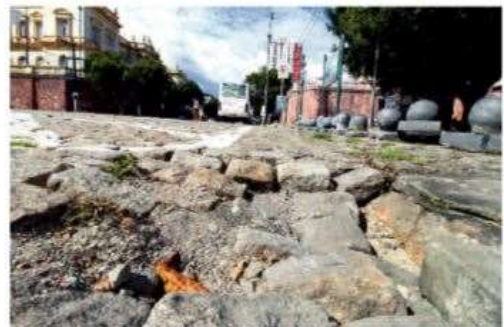
Segundo a Seminf, a ação do tempo é um dos fatores que causam os afundamentos
