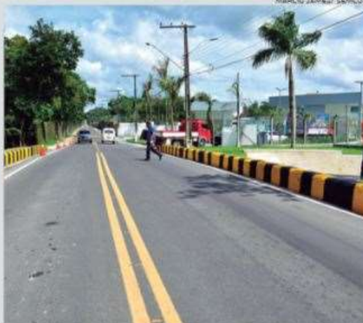
Via passou por serviços de infraestrutura, paisagismo e iluminação a LED
