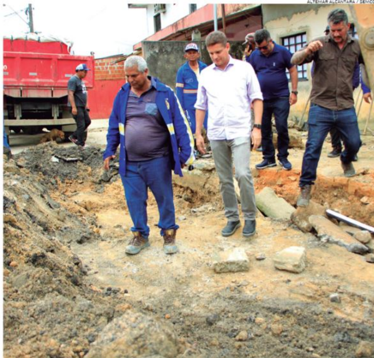
Vice-prefeito Marcos Rotta e comitiva estiveram na comunidade Parque São Pedro, no bairro Tarumã, Zona Oeste visitando as obras
