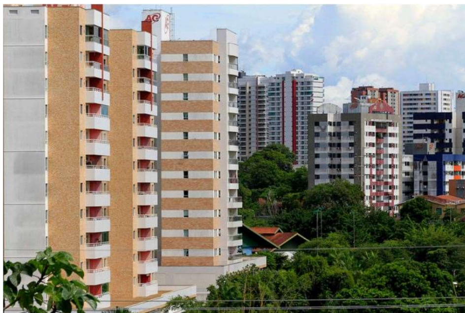
O Sinduscon-AM estima que a construção civil do Estado cresceu 10%, no ano passado, em relação a 2017 (Foto: Arquivo/Semcom)
