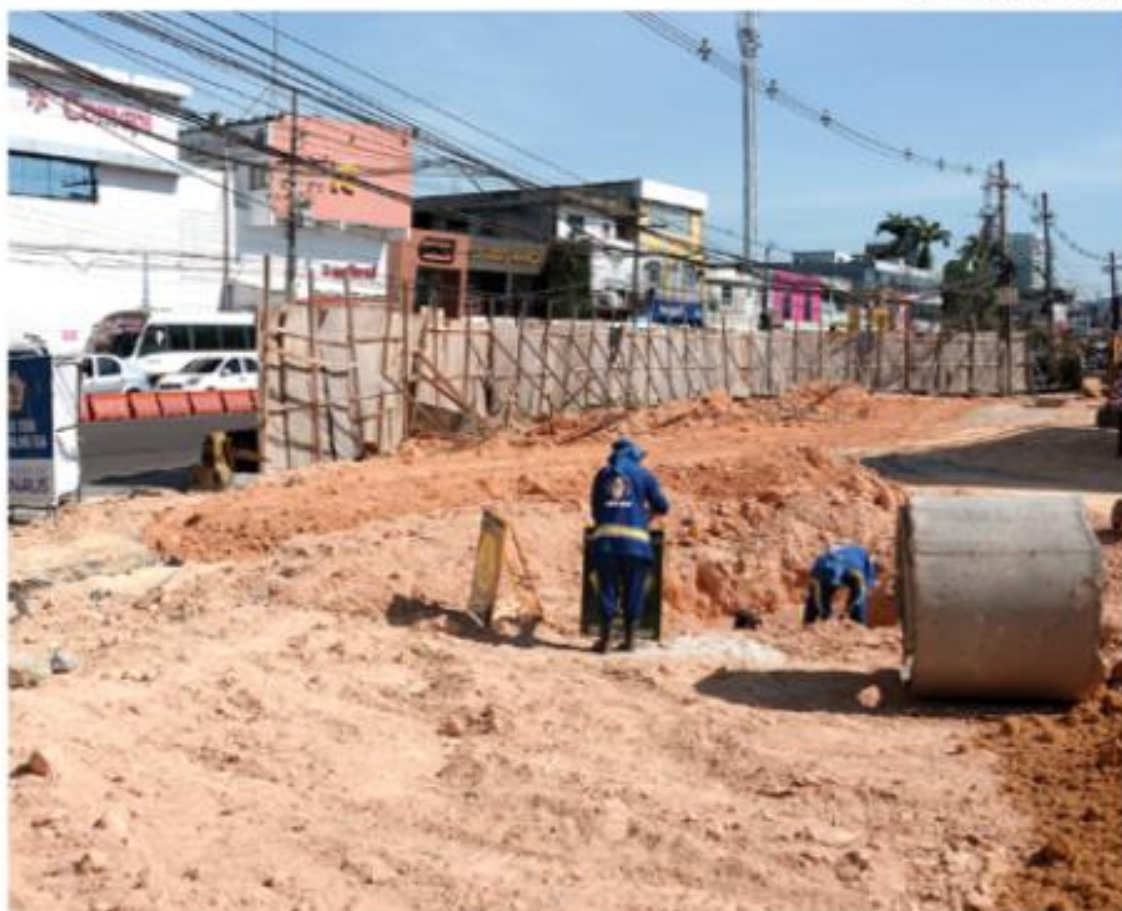
Obras na avenida Djalma Batista receberão os trabalhos de preparação para asfalto
