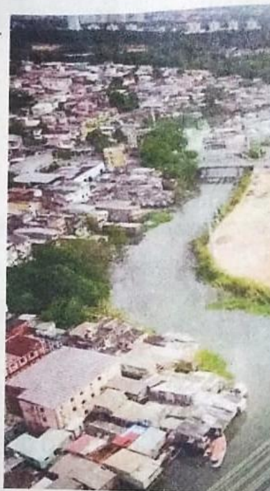
Obras chegaram a ficar paradas por pelo m
