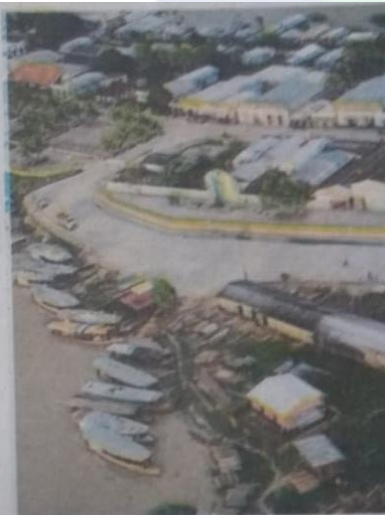
Envira não possui infraestrutura adequada
