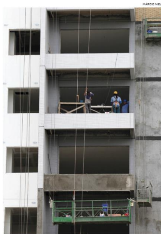
Construção civil foi o segundo setor que mais demitiu trabalhadores, o primeiro foi a indústria
