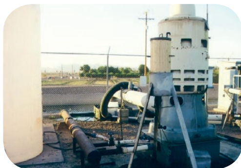
Sistema de Poço de Injeção/Produção do SRP, Arizona, com detalhe da vazão injetada no canal principal
