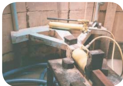
À esquerda, fase da colocação das placas; e à direita, injeção de um dreno por macaco hidráulico. Fonte: Sá (1999)
