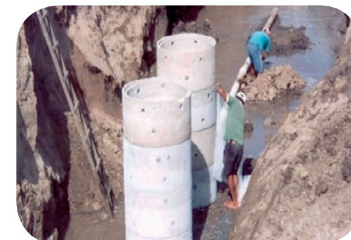
Poço com anéis de concreto
