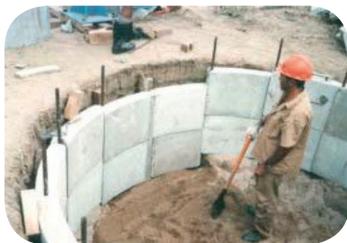
À esquerda, fase da colocação das placas; e à direita, injeção de um dreno por macaco hidráulico. Fonte: Sá (1999)
