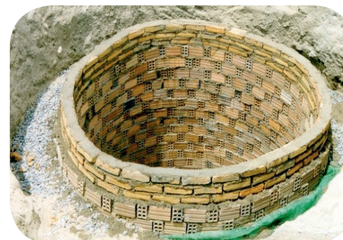
Poço amazonas feito com tijolos
