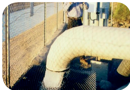
Sistema de Poço de Injeção/Produção do SRP, Arizona, com detalhe da vazão injetada no canal principal
