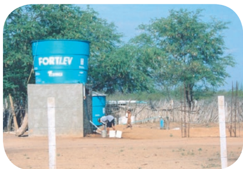
Chafariz/caixa d'água com base em alvenaria
