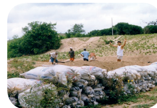
Enrocamento com sacos de areia
