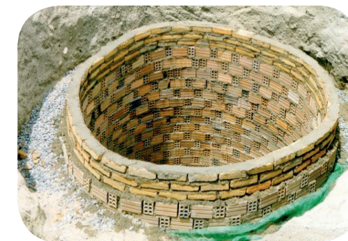
Poço de tijolos/alvenaria
