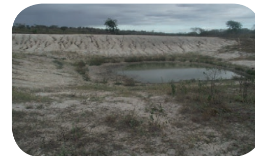
Reservatório praticamente vazio pela ausência de água de escoamento superficial
